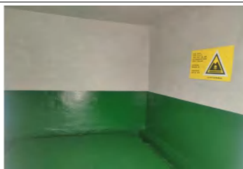
危险固暂存间场内部
