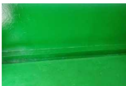
危险固废堆场防渗措施
