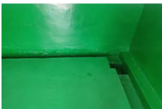
危险固废堆场防渗措施
