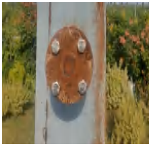
排气筒取样口
